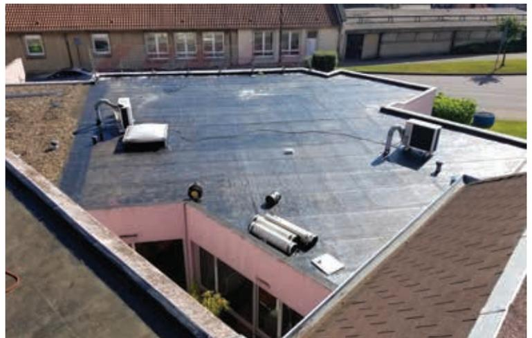
Afin de remédier aux problèmes d'infiltration d'eau dans la salle des fêtes et au centre social lors de fortes pluies, l'ensemble de la toiture a été remplacé.
