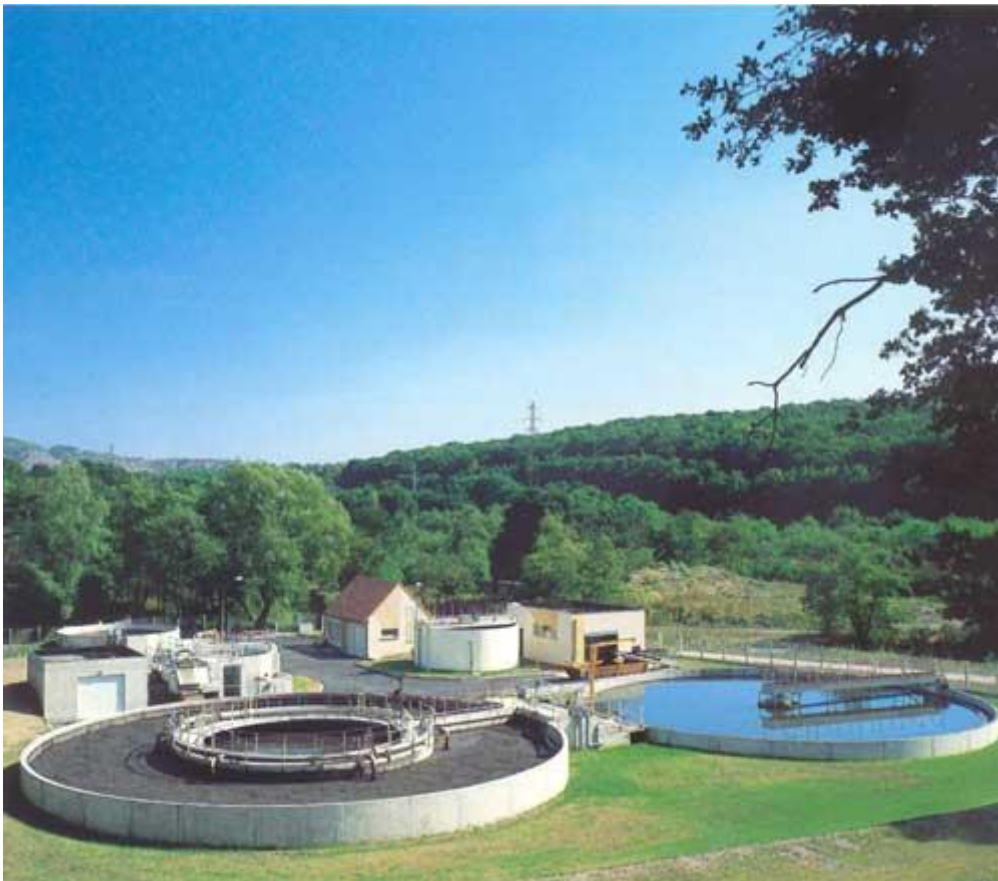
Station d'épuration située derrière la gare de L'Hôpital
